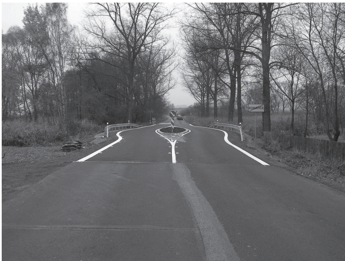
(obr. 3) Střední dělicí ostrůvek na silnici II/268, začátek/konec obce Bohatice
